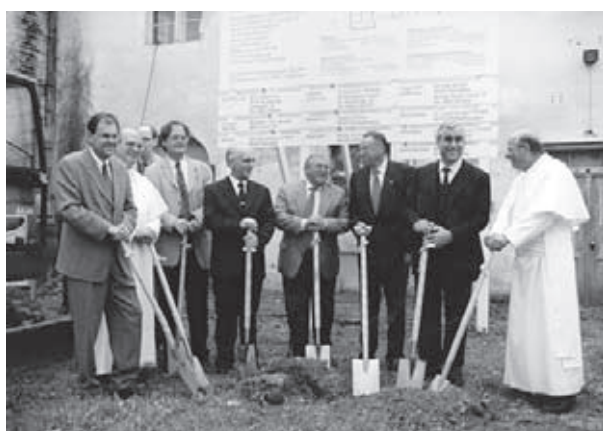
Ein historischer Moment: Erster Spatenstich zur Renovierung des Prälatengartens
